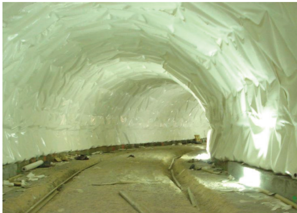
تونل خط ۷ مترو - تهران
